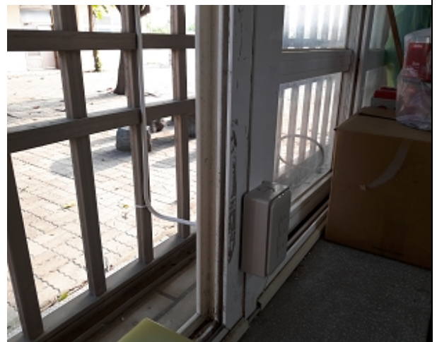
電線安裝完工
