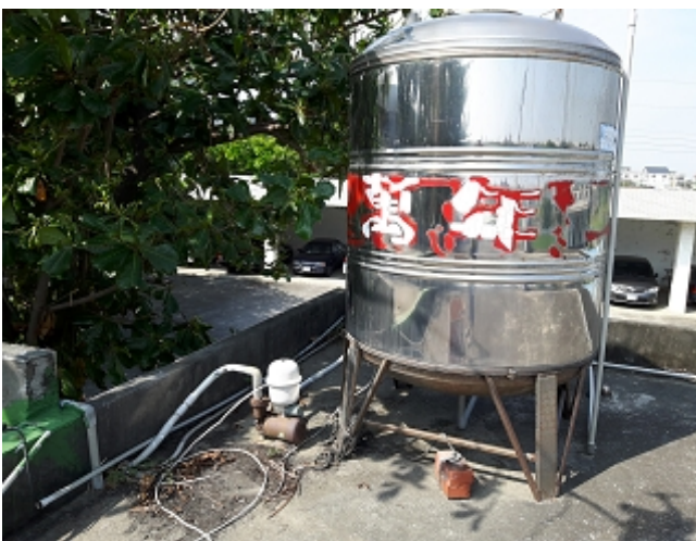
水塔水管安裝完工
