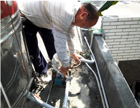
水塔水管安裝
